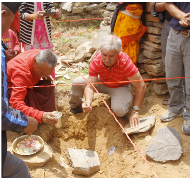
Nach dem großen Beben : Grundsteinlegung mit Günther Strödel für das erste von 100 Häusern.
