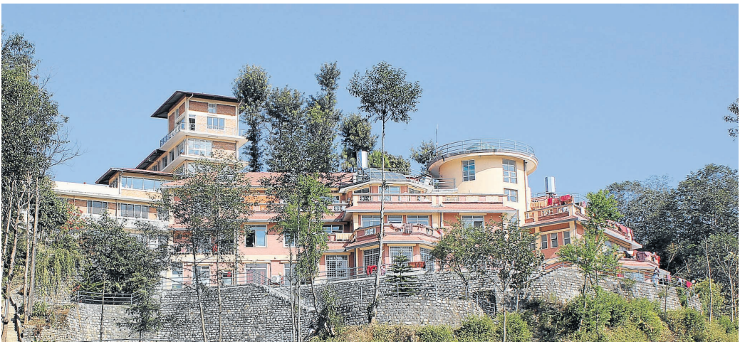
Leuchtturmprojekt: Das Krankenhaus in Dhulikhel ist dank Spenden aufgebaut worden und ermöglicht über einen Charity-Fond auch armen Menschen eine Behandlung.
