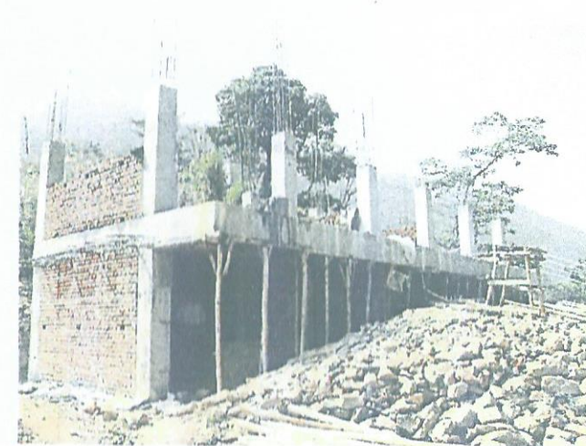
Der Neubau der Schule , die bei dem schweren Erdbeben im Jahr 2015 zerstört wurde, soll nächstes Jahr fertiggestellt werden. Günther Strödel fotografierte die Bauarbeiten in Bolde bei seinem jüngsten Besuch.
