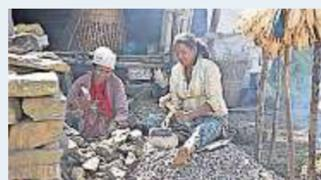
**Handarbeit:** In mühevoller Kleinarbeit zertrümmerten Frauen Steine der zerstörten Häuser. Der so entstandene Kies-Ersatz wurde für die neuen Fundamente verwendet.
